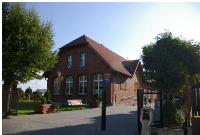
Barut – świetlica wiejska i biblioteka.
