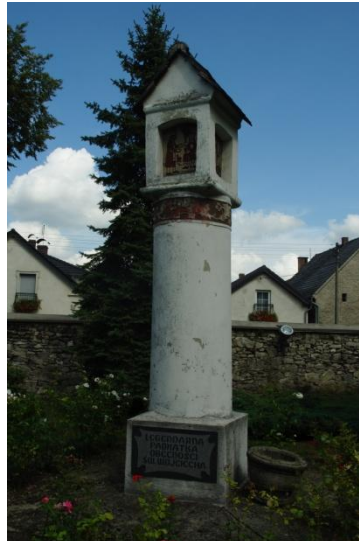
Jemielnica - kapliczka św. Wojciecha w ogrodzie klasztornym. Na cokole kolumna zwieńczona latarnią z daszkiem dwuspadowym. W bokach latarni odcinkowe nisze. Pod abakusem sgrafitowy fryz.
