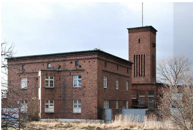
Zdjęcie nr 39. Budynek biurowy rzeźni w Strzelcach Opolskich
