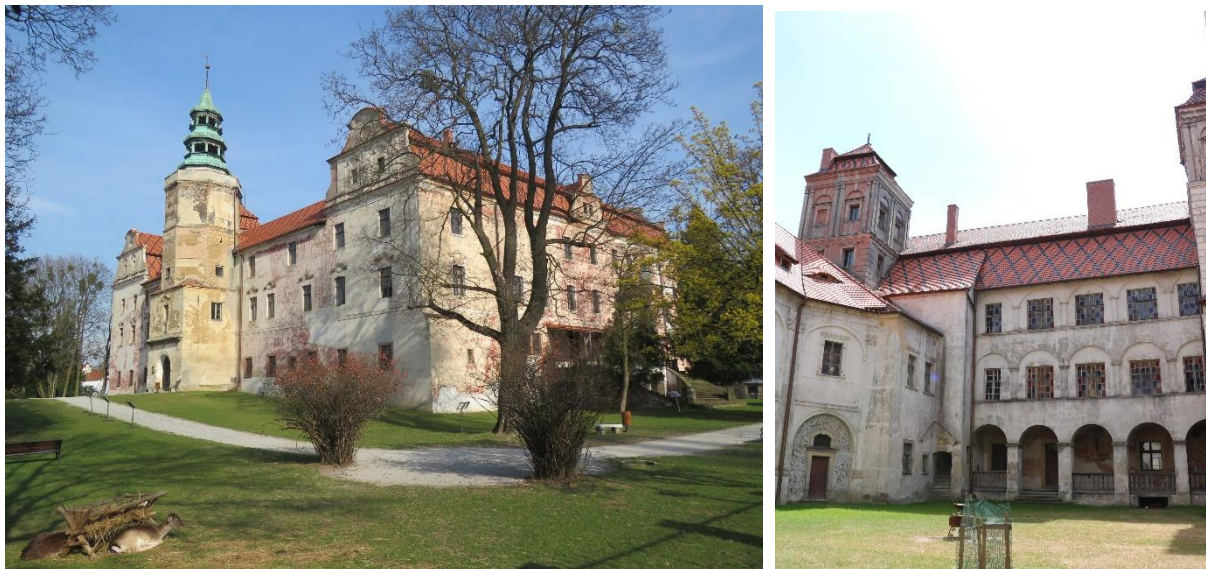
Ryc. 24 Niemodlin, zamek, elewacje zewnętrzne i dziedzińiec, fot. I. Solisz
