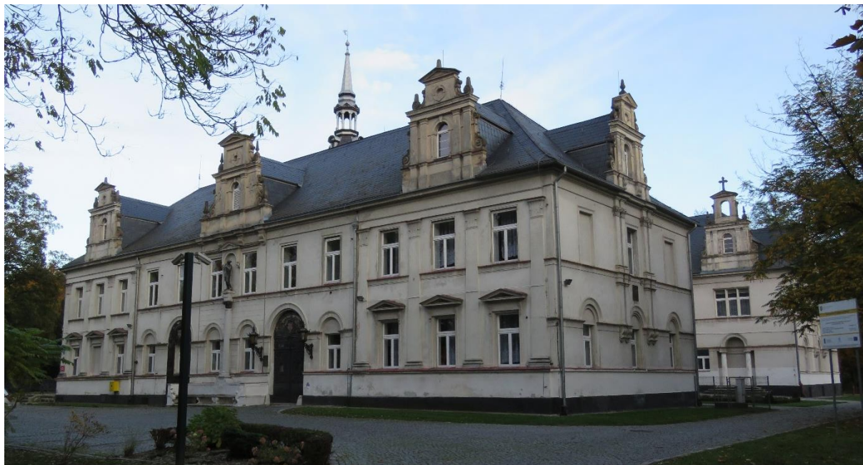
Ryc. 3 Pałac w Tułowicach
