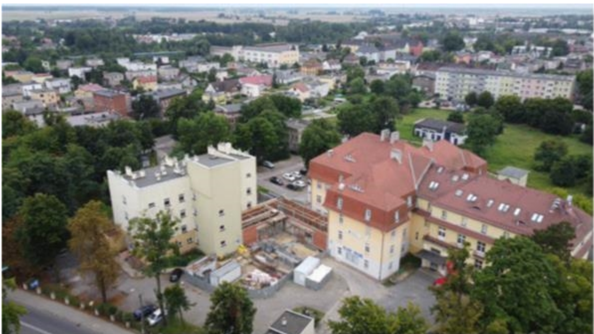
Budowa łącznika w Powiatowym Centrum Zdrowia S.A.
