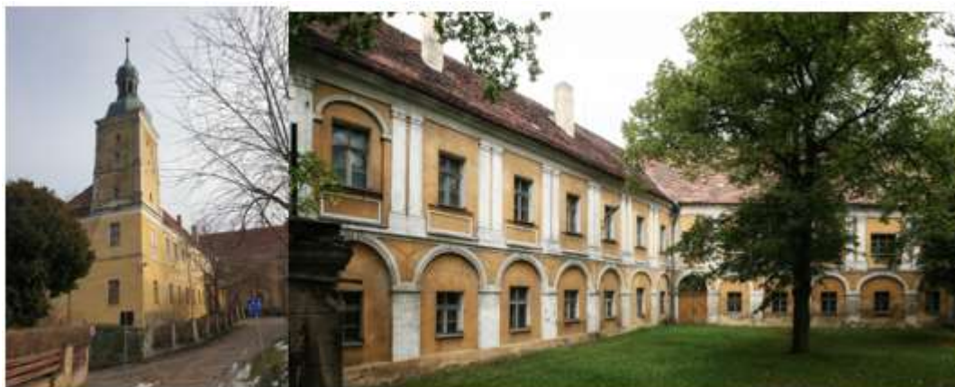
Fotografia 5. Widok na Zamek w Białej od strony południowo – wschodniej.
