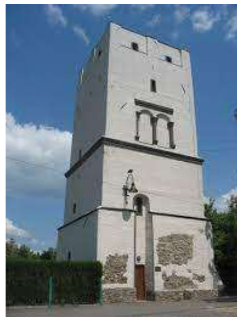
Fotografia 22. Widok na wieżę wodną w Białej.
