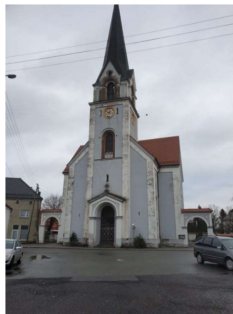
Fotografia 15. Widok na Kościół pw. Nawiedzenia NMP w Łączniku.
