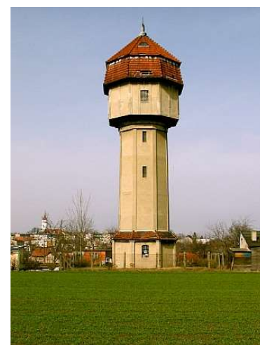
Fotografia 25. Widok na wodociągową wieżę ciśnień w Białej.
