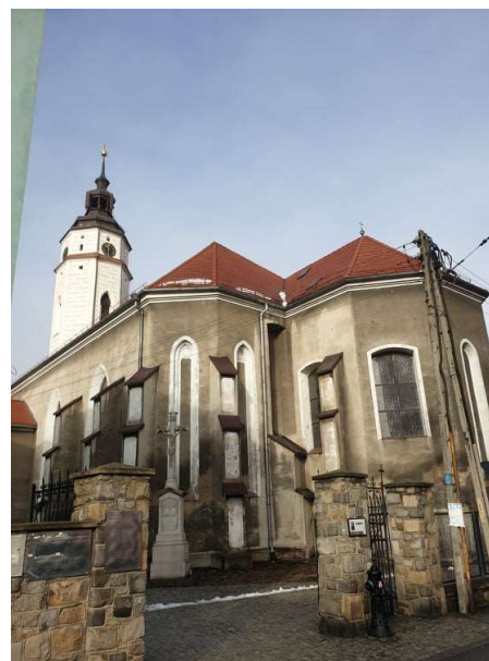
Fotografia 7. Widok na kościół pw. Wniebowzięcia NMP w Białej.
