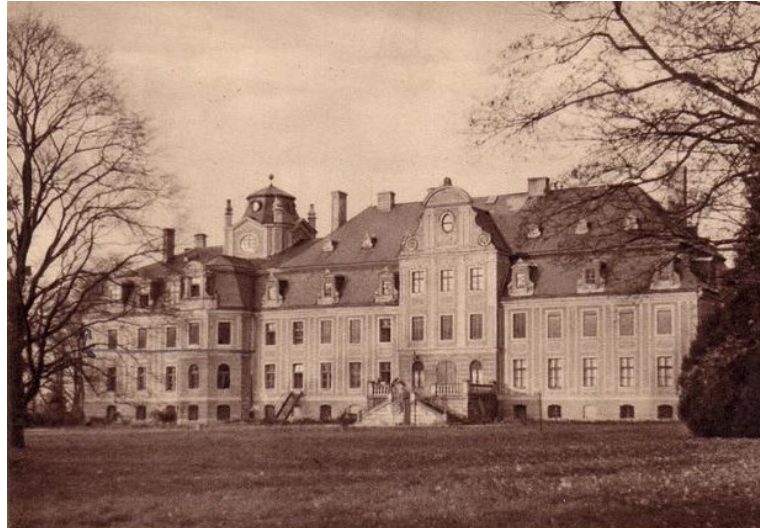
Fot. 3. Pałac w Gręboszowie
