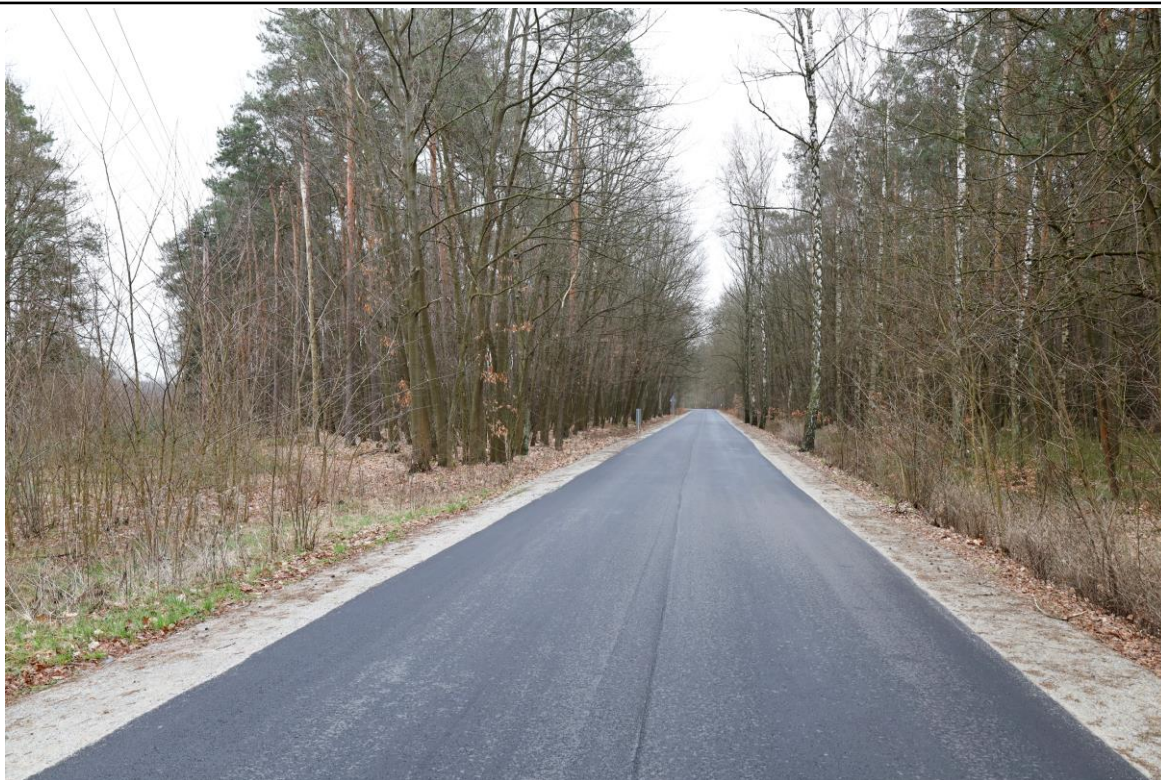
Fot. Droga powiatowa 13160 Chocianowice
