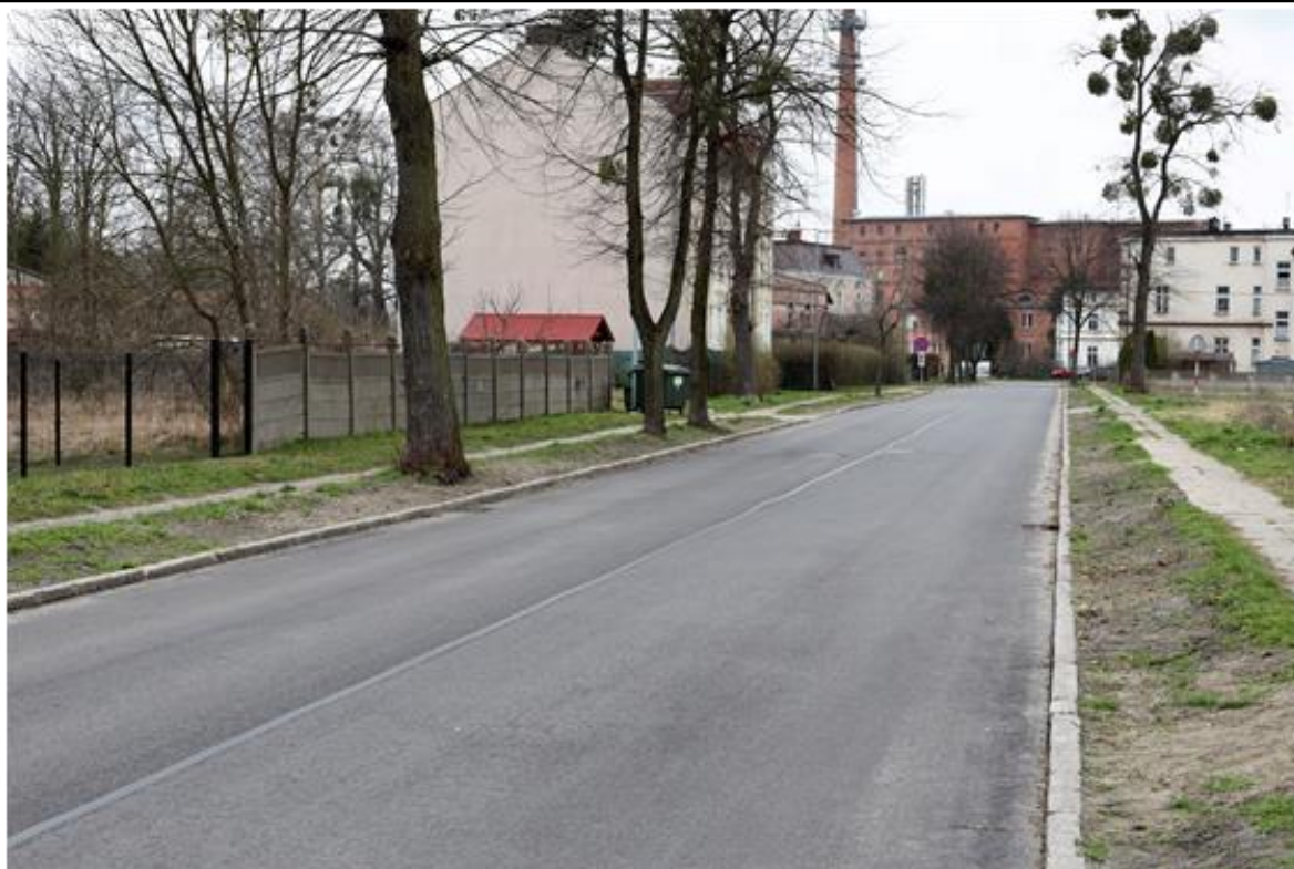
Fot. Droga powiatowa 22920 ul. Drzymały w Wolczynie
